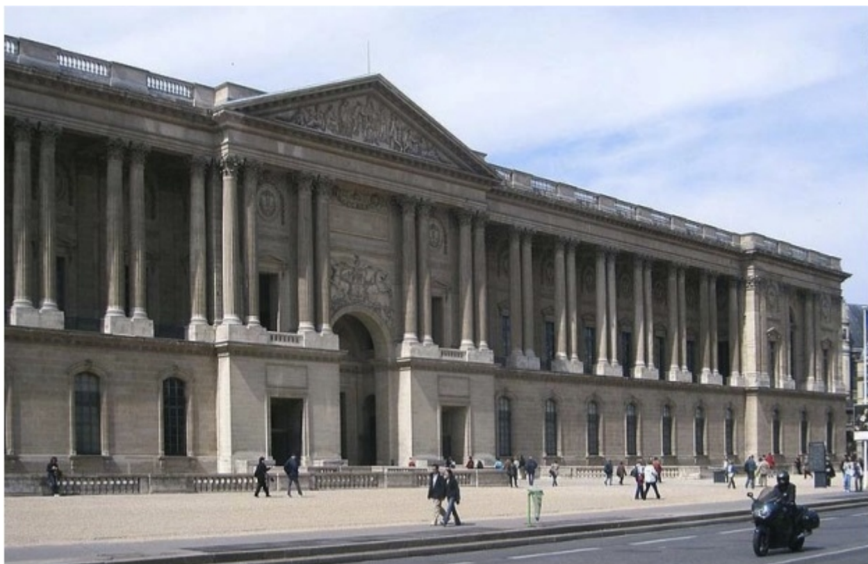
Рис. 39. Восточный фасад Лувра. 1667-1678. Клод Перро
