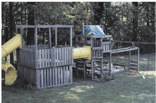
Рис. 8.30. Этот снимок пригодился мне при общении с представителем страховой компании, когда конструкция была разрушена упавшим деревом
