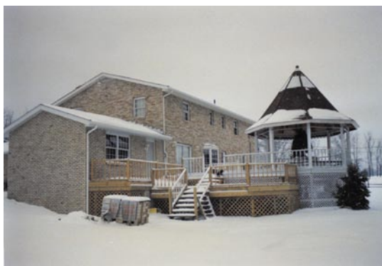
Рис. 8.28. Задокументируйте недостроенное сооружение, чтобы знать, что еще предстоит доделать
