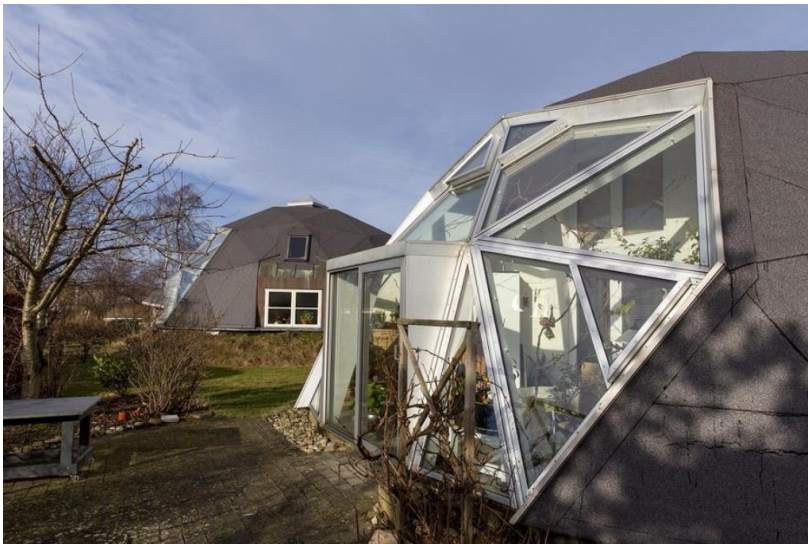
Рисунок 1.16. Теплиця на даху
