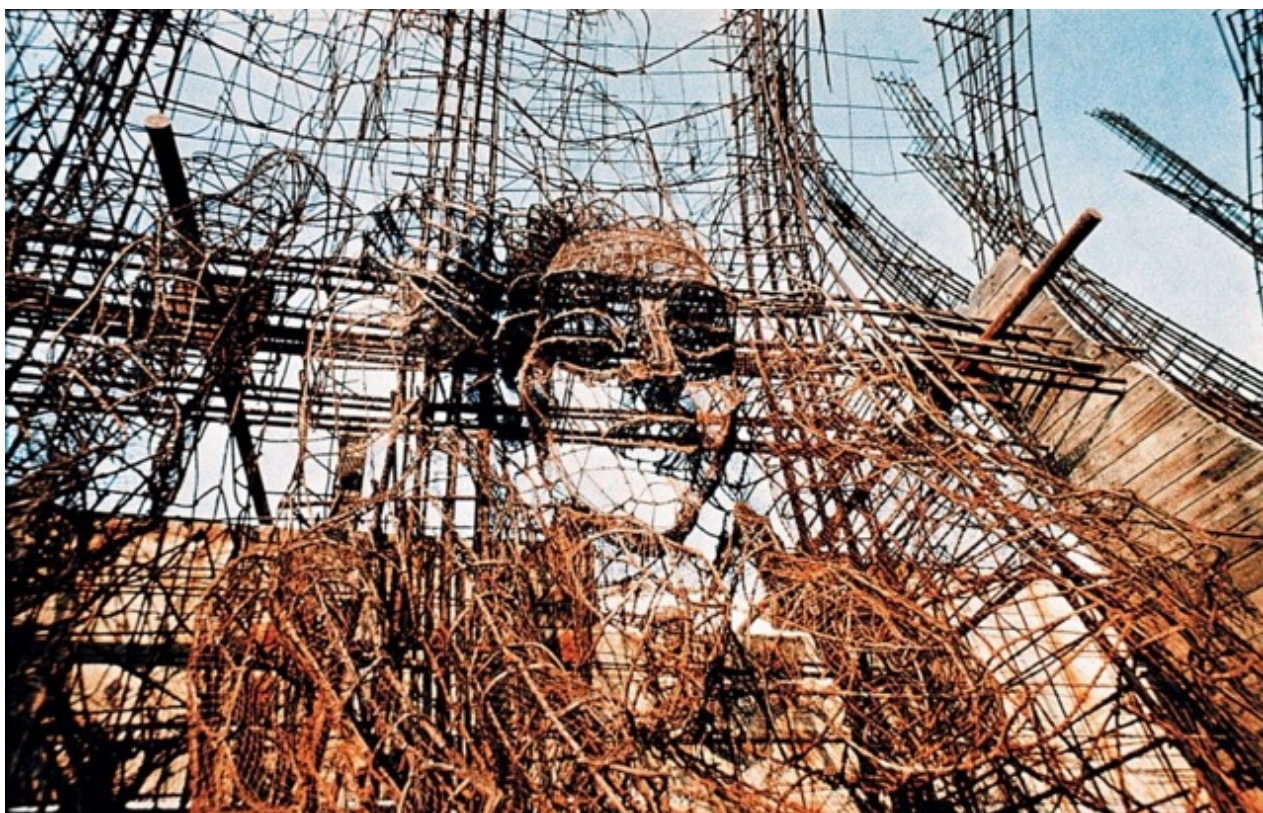
Рис. 2.17. Готовий каркас перед нанесенням бетону
