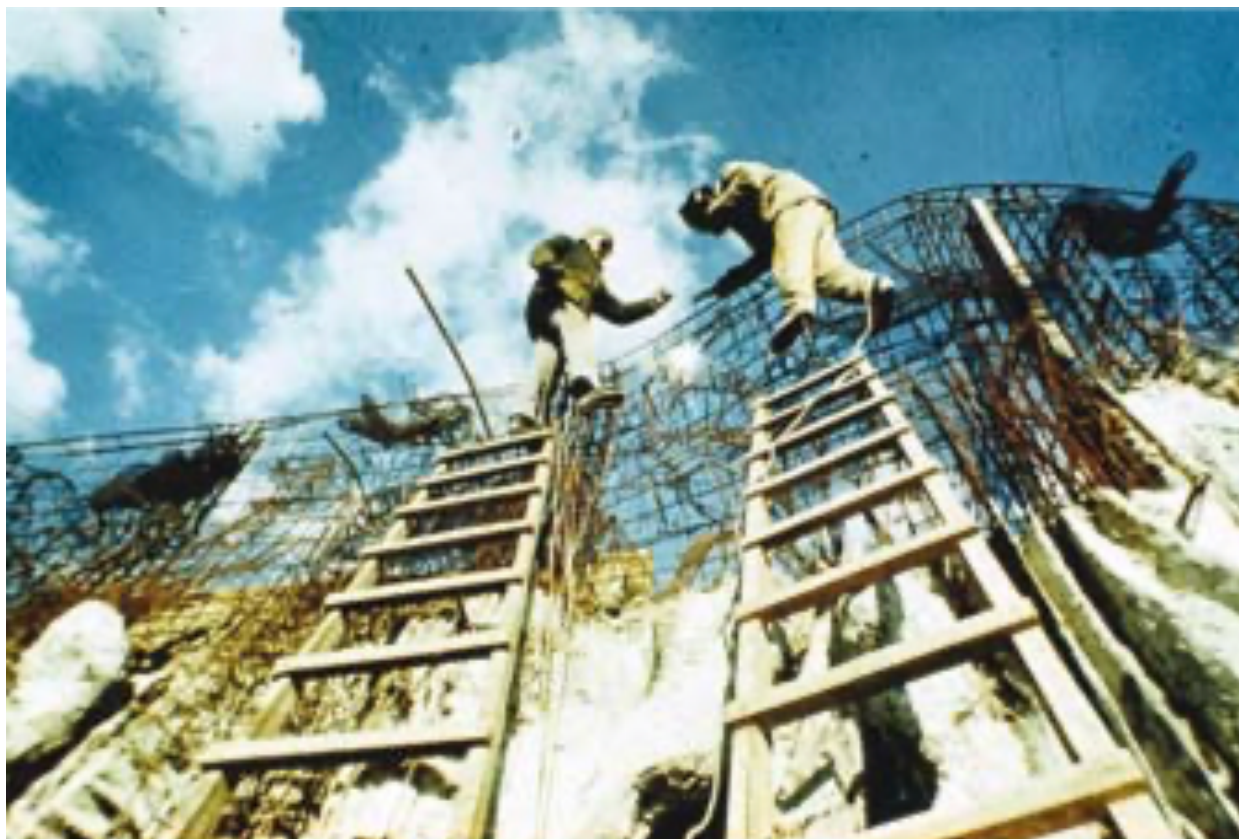
Рис. 2.16. Металевий каркас, до якого приварювалася сітка по формі рельєфу
