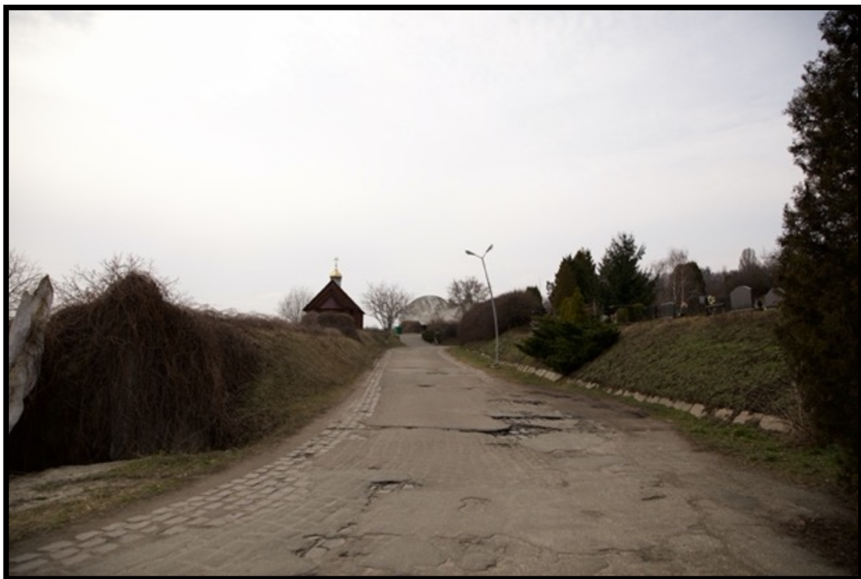
Дорога до церкви. Асфальт поверх бруківки
