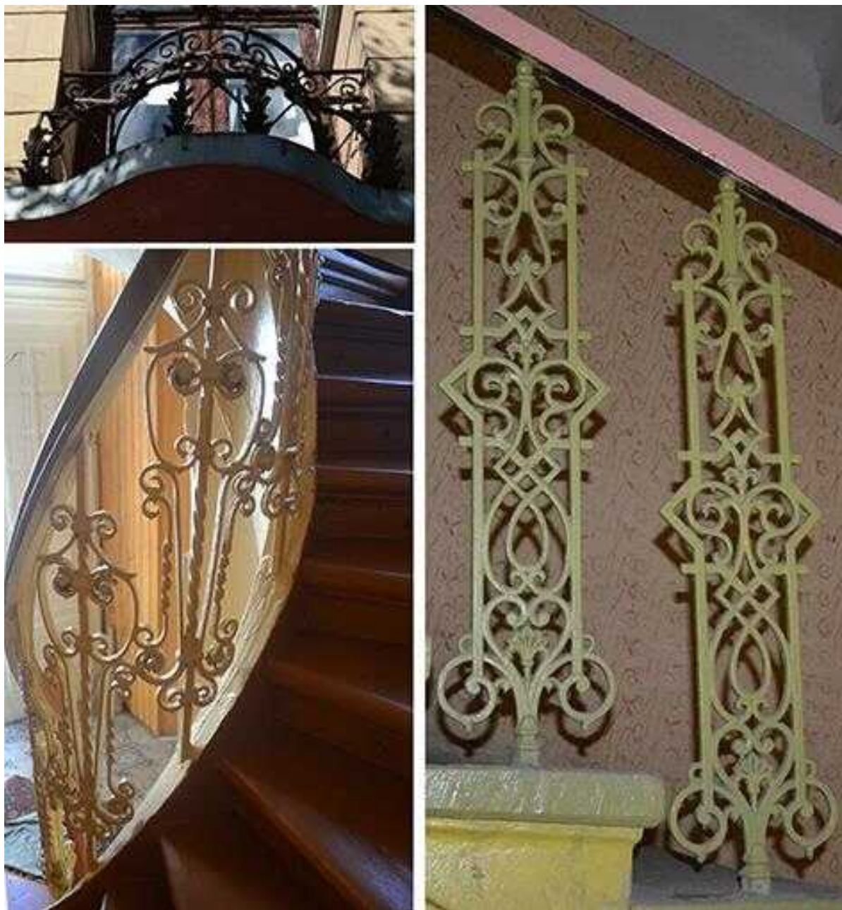
Іл. 7. Огородження балкона по вул. Гетьмана Мазепи, 10 (1896), огороження сходових маршів, будинків по вул. Шевченка, 102 (1896-97 рр.), Гетьмана Мазепи, 11 (1890-ті рр.).
