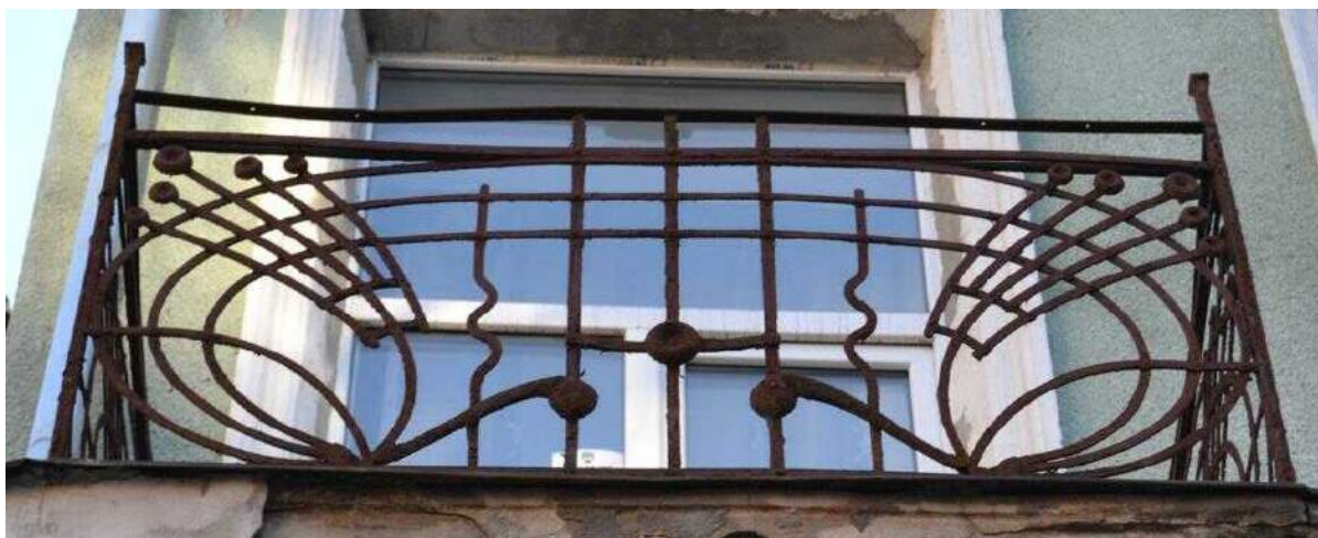
Лл. 16 - б. Балконне огородження. м. Івано-Франківськ, вул. Січових стрільців, 74 (після 1900-тих рр.). Світлина 2013 р.
