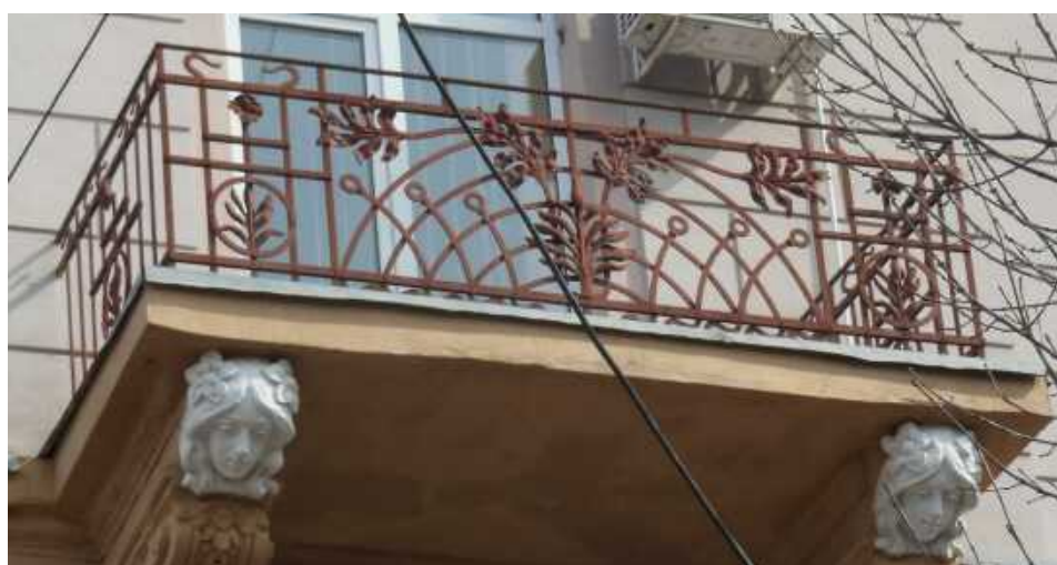
Лл.17 - б. Балконне огороження. м. Івано-Франківськ, вул. Січових стрільців, 15 (1909 р.).Світлина 2013 р.
