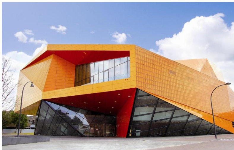
Кінотеатр у м. Лелістад (Нідерланди), облицьований панелями композитного матеріалу
