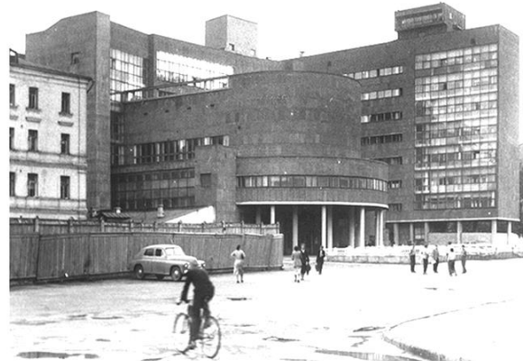
Будинок Центросоюзу в Москві (1928-1933 рр.)
