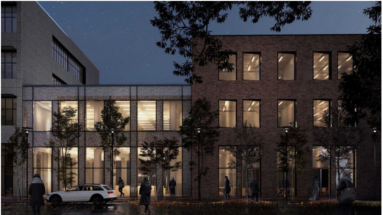
Рис.30 Інноваційний центр на базі старого заводу Промприлад
