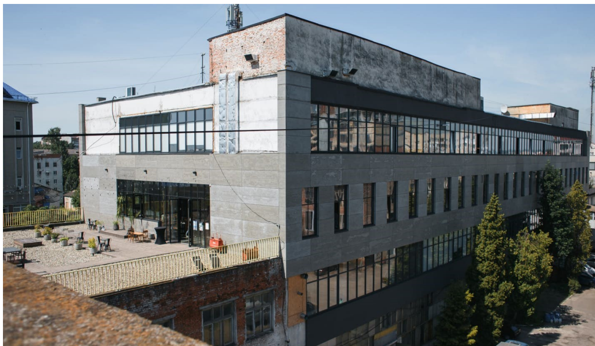
Рис.29 Інноваційний центр на базі старого заводу Промприлад
