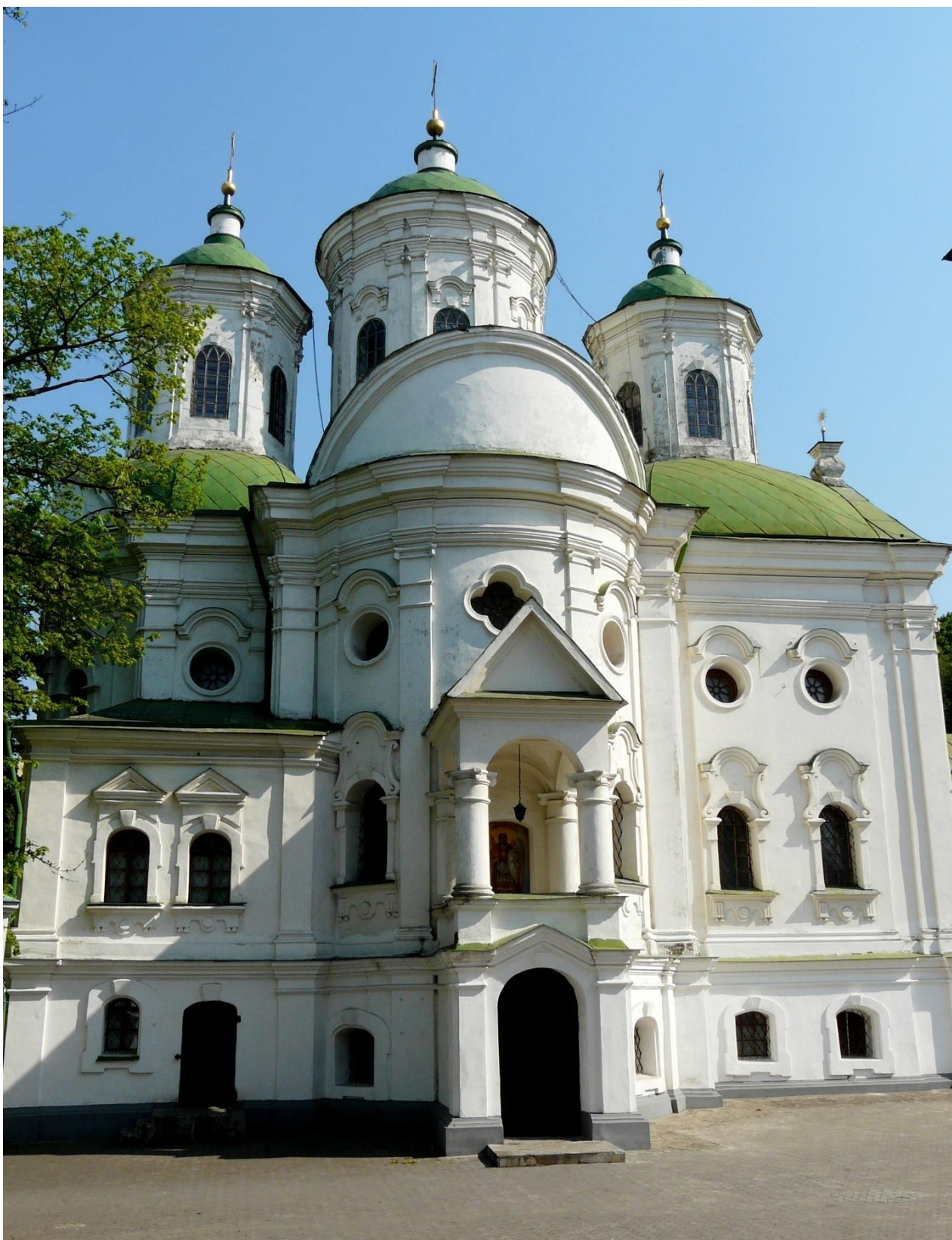
Іл.25. Покровська церква на Подолі, м. Київ.
