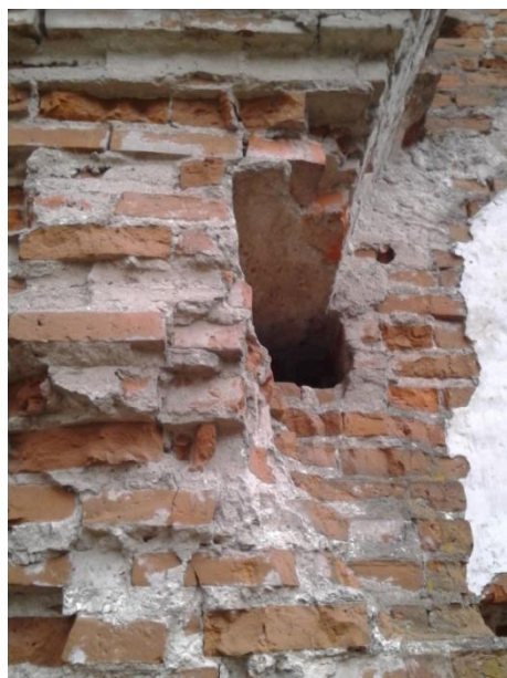
Мал.16. Фрагмент стіни храму з «гличиком» для акустики.
