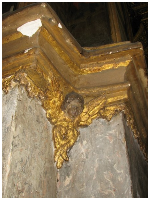
Б. Рис. 145. Втрати ліпного оздоблення. Фото В. Зайцевої
