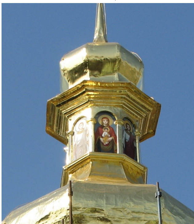
Б. Рис. 154. Ліхтар куполу Троїцької надбрамної церкви після реставрації. Фото В. Зайцевої
