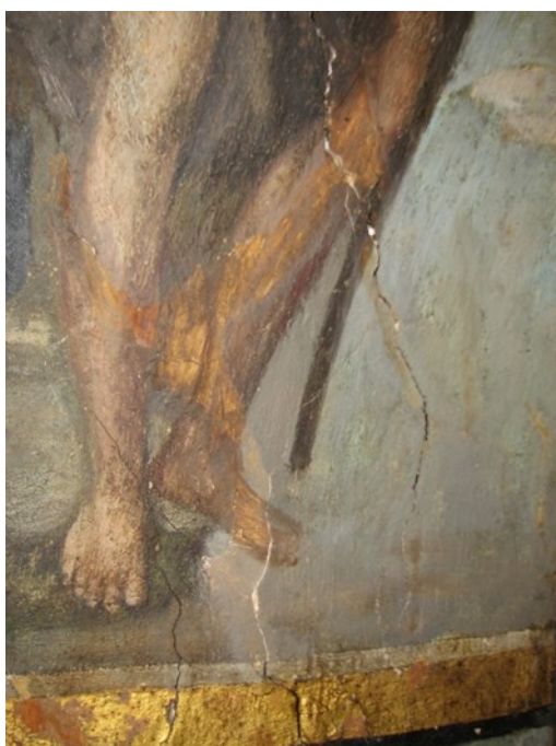
Б. Рис. 138. Верхня ділянка тріщини над входом до паламарні. Фото В. Зайцевої
