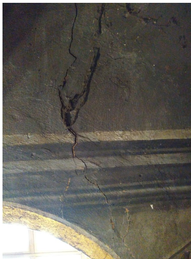
Б. Рис. 141. Тріщина з відшаруванням штукатурного шару з загрозою осипання на західній стіні північного нефа. Фото В. Кравцова
