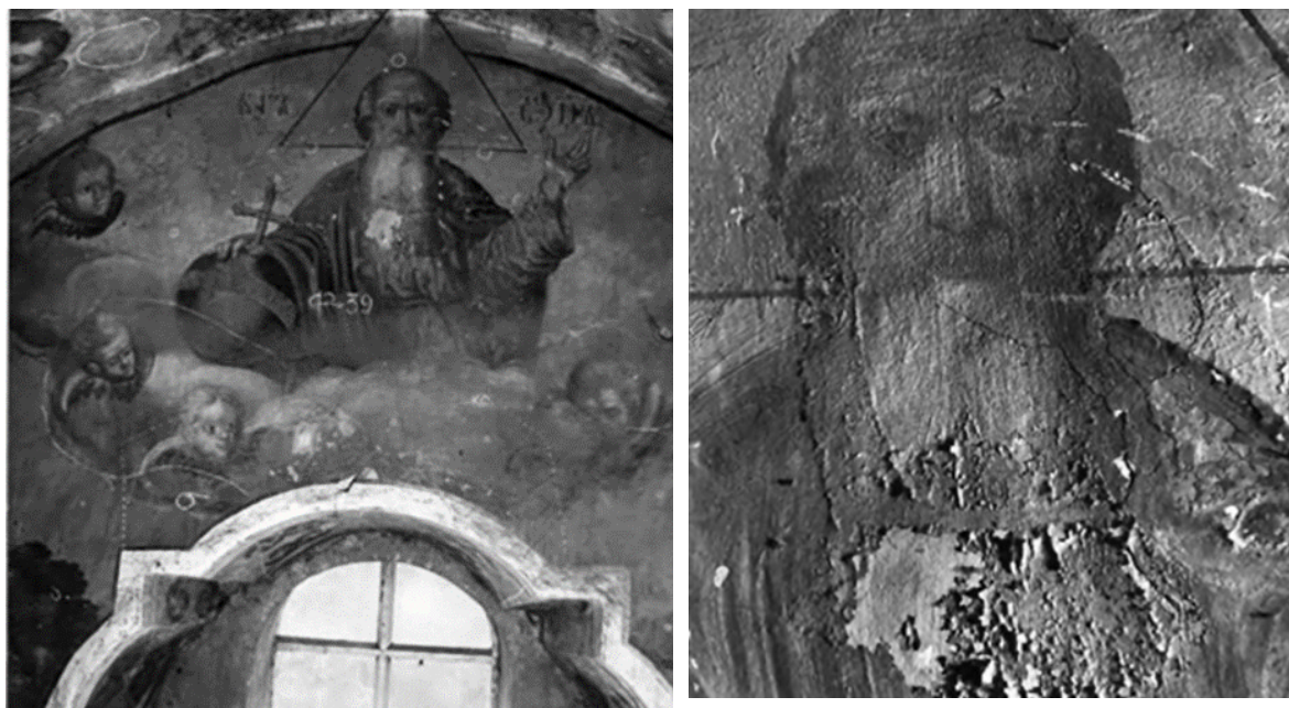
Б. Рис. 49. Втрати та відшарування фарбового шару на композиції південної стіни трансепта [47].
