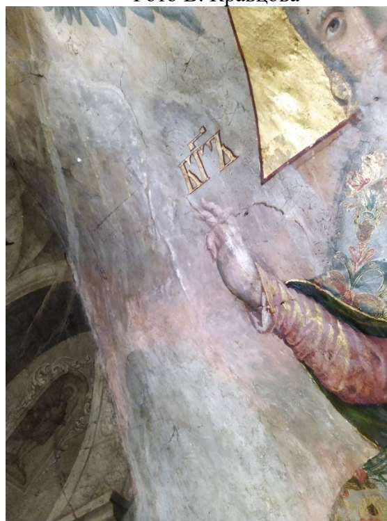
Б. Рис. 141. Тріщина з відшаруванням штукатурного шару з загрозою осипання на західній стіні північного нефа. Фото В. Кравцова
