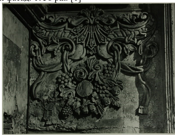
Б. Рис. 29. Стан ліпнини фасадів Троїцької надбрамної церкви. 50-ті рр. XX ст. НЗКПЛ, КПЛ-ф-983
