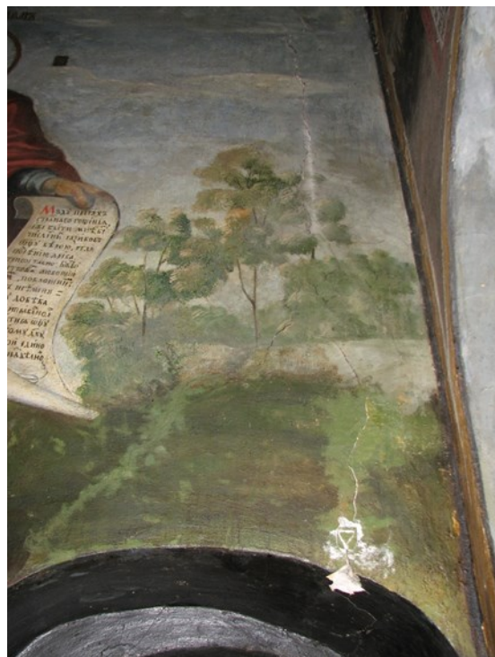
Б. Рис. 137. Розгалужена тріщина з відшаруванням штукатурного шару на східній стіні (над входним прорізом до паламарні). Фото В. Зайцевої
