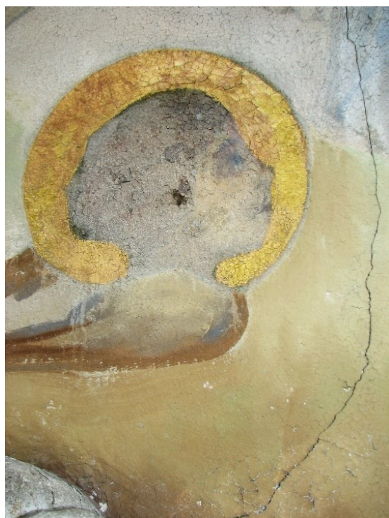
Б. Рис. 124. Фрагмент стінопису західного фасаду до реставрації. 2019 р. Фото В. Зайцевої
