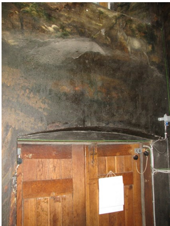
Б. Рис. 136. Тріщина в східній частині північної стіни галереї притвору та на площі відкосу дверного прорізу. Фото В. Зайцевої
