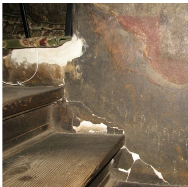
Б. Рис. 137. Розгалужена тріщина з відшаруванням штукатурного шару на східній стіні (над входним прорізом до паламарні). Фото В. Зайцевої
