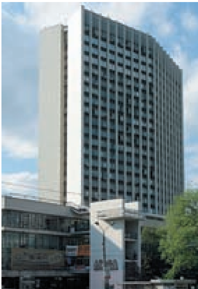
В. Єжов, І. Лошаков та ін. Будинок торгівлі в Києві. 1982
