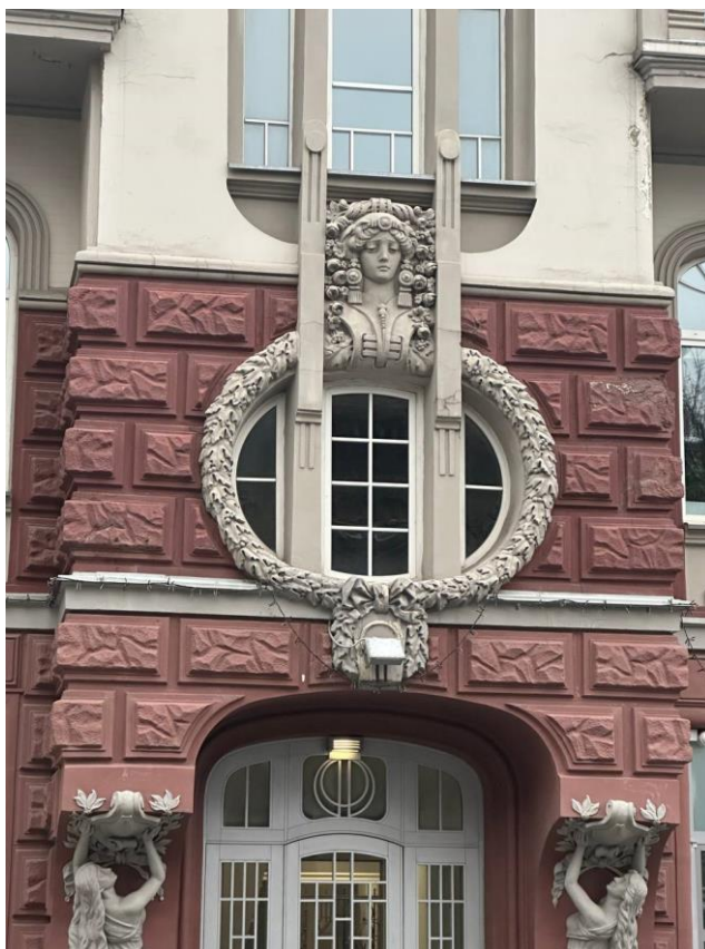
Рис.3.8. Оздоблення центрального ризаліту. Будинок Родзянка на вул. Ярославів Вал, 14, Київ. Арх. М. Круг, 1910. Головний фасад. Фото: В. Бублик
