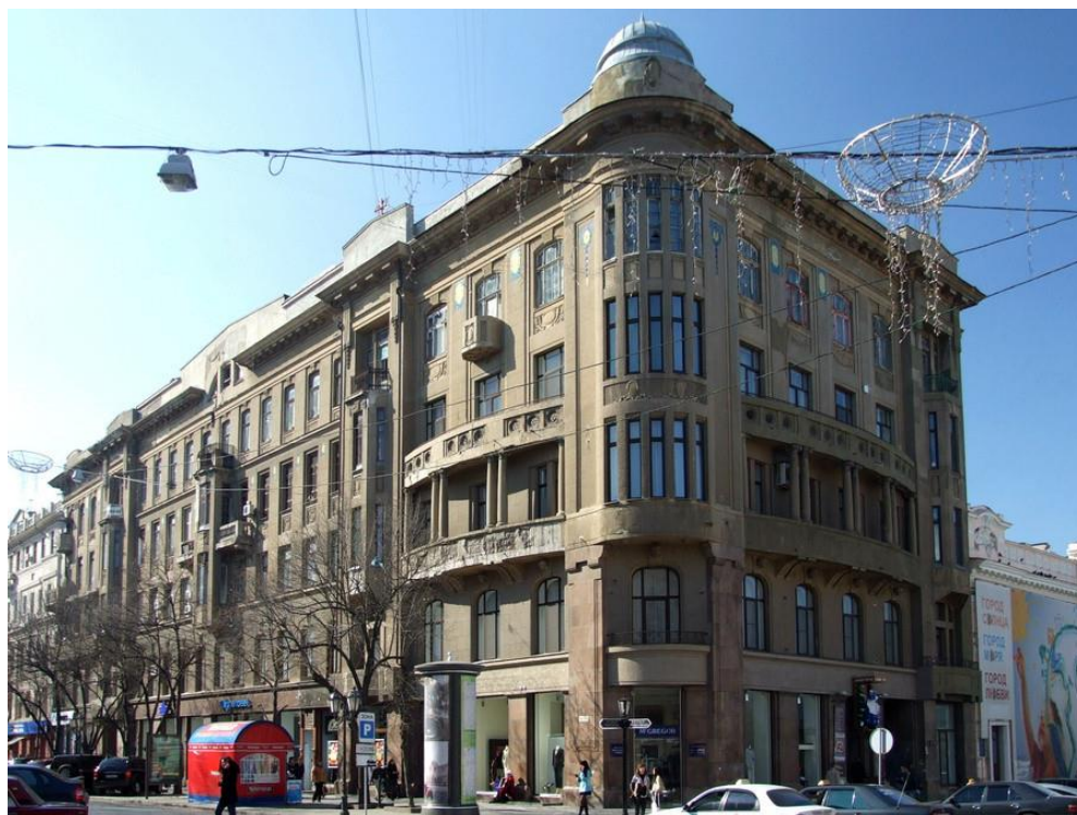
Рис.1.5. Будинок Новікова, арх. С.А. Ландесман, 1912–1913 рр., Дерибасівська вул., 12 / Рішельєвська вул., 4. Фото з відкритих джерел
