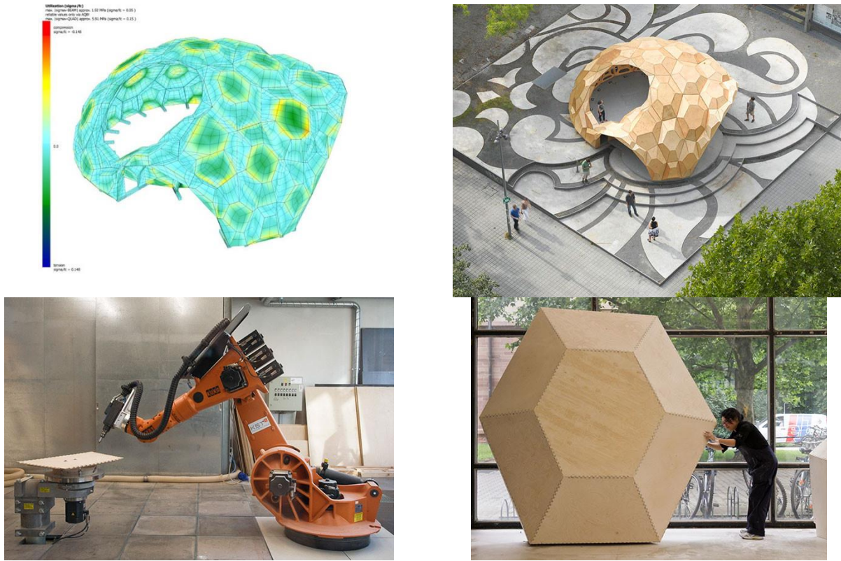
Рис. 11. Біонічний павільйон з дерева. Штутгарський університет.
