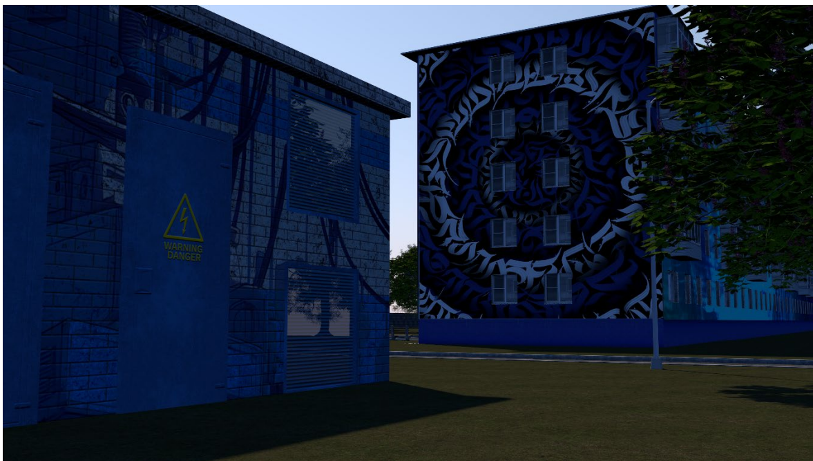
Рис. 3.3. Оформлення електрощитової в ідентичному дизайн кодї з основною будівлею.
